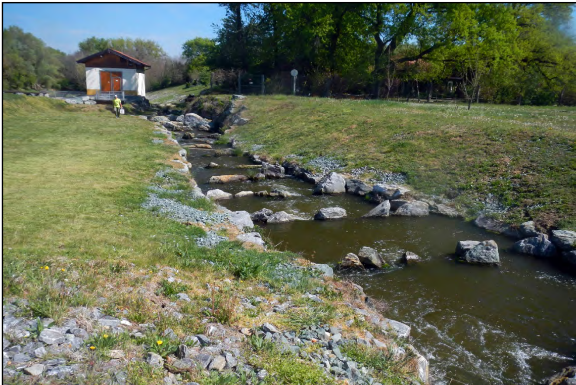
4. kép. Az ikervári duzzasztó mellett épített halcsatorna természetszerű szakasza
