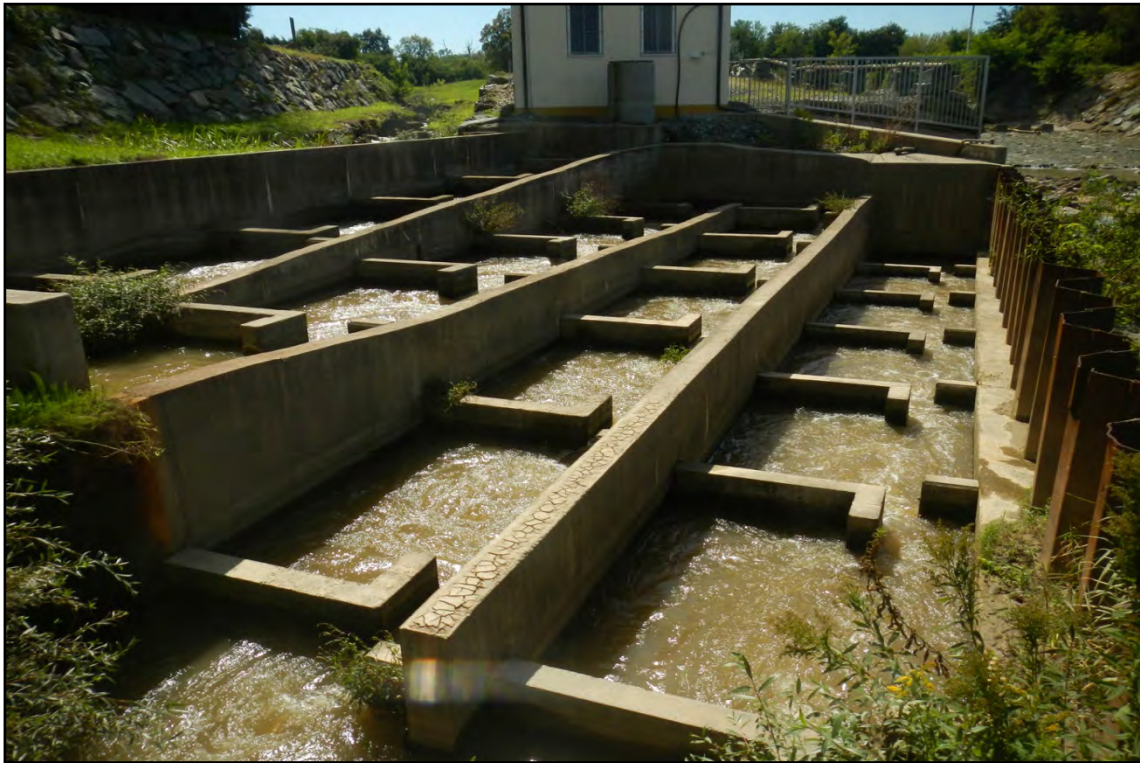
3. kép. Az ikervári duzzasztó mellett épített réselt halátjáró, a halcsatorna kezdeti szakasza
