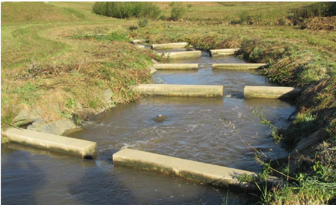
Abbildung 97: Naturnaher Beckenpass oberhalb der Einmündung des Grieselbaches. Foto: W. Lazowski
