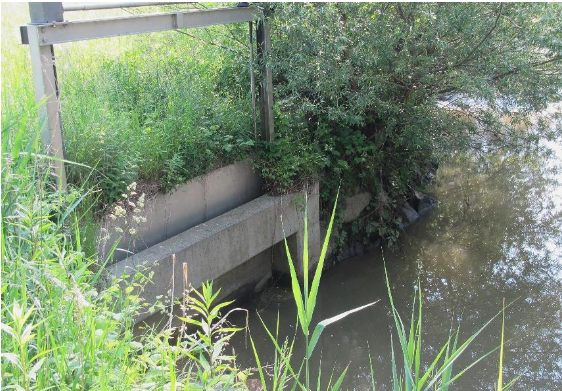
Abbildung 98: Rahmendurchlass in den Altarm bei Jennersdorf, linksufrig, oberhalb der Straßenbrücke (B57). Foto: W. Lazowski
