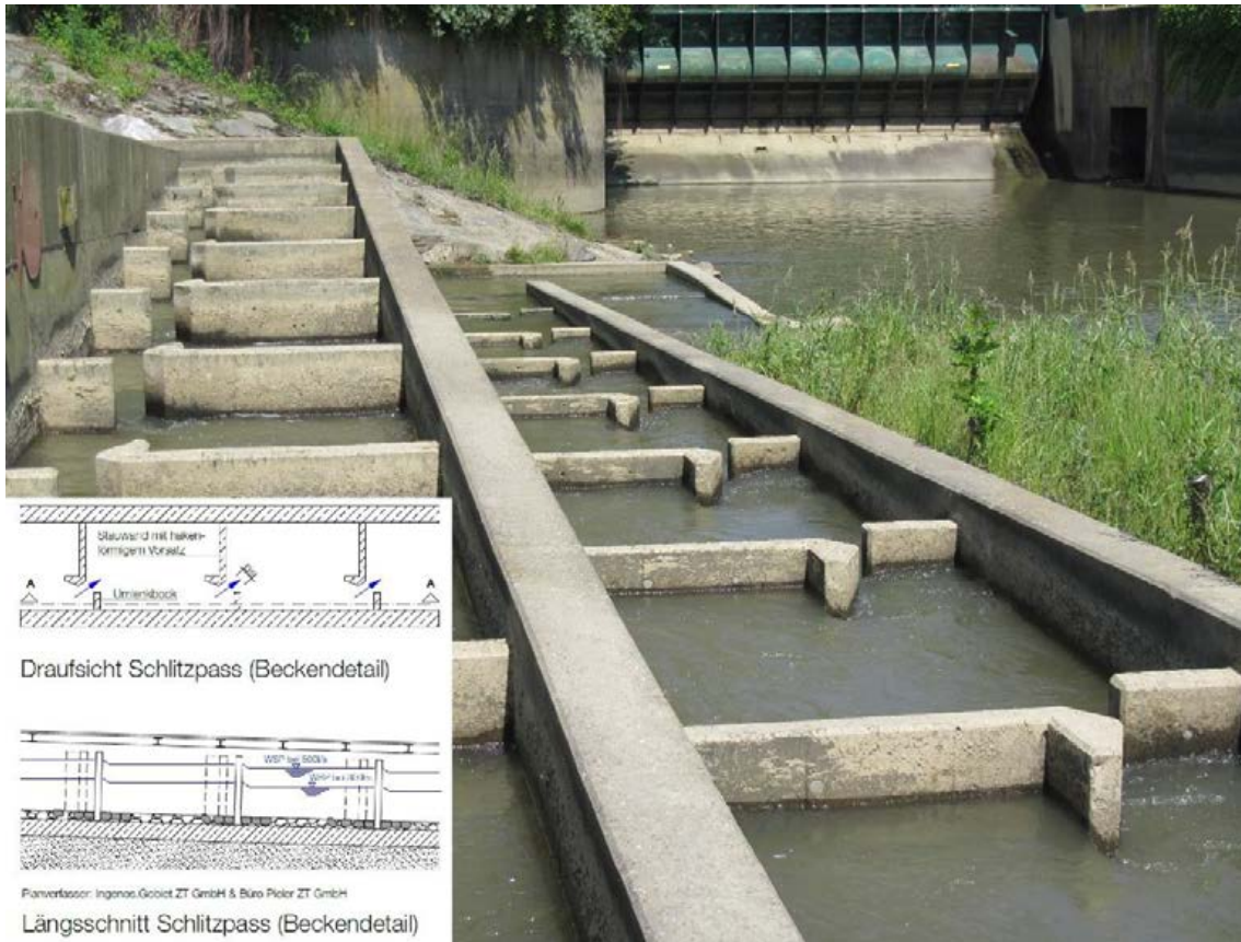
Abbildung 94: Schlitzpasstreppe beim KW Hohenbrugg; Grafik: Amt der Steiermärkischen Landesregierung A14 (s. Fußnote 18). Foto: W. Lazowski
