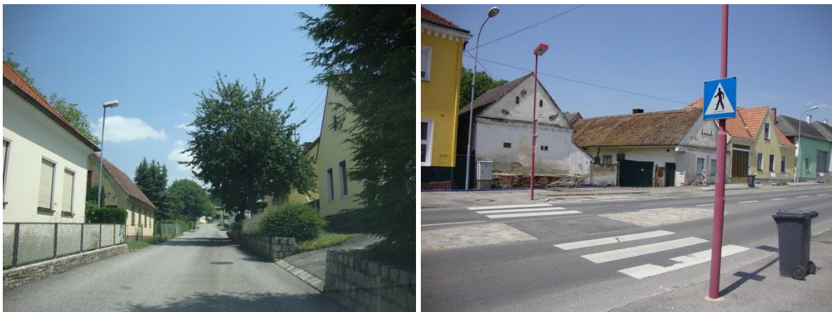
Abb. 3. Fußgängeranlagen links: fehlender Gehsteig, rechts: Fußgängerquerung (Quelle: eigene Fotos)
