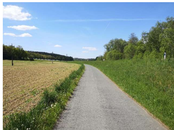
Begleitweg entlang der L240 zwischen St. Martin in der Wart und Oberwart
