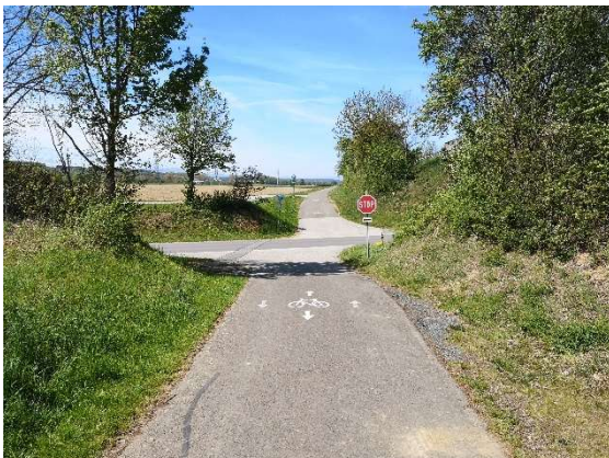
Radroute Oberwart-Großpetersdorf quert die Straße Unterwart-Industriegebiet mit schlechter Einsehbarkeit
