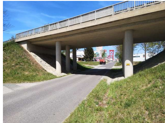
Letzter Abschnitt vor Industriegebiet (Unterführung B63a) ohne Radinfrastruktur
