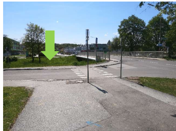
Schulgasse Problemstelle Pinkaquerung (Pfeil = Standort möglicher Radbrücke)
