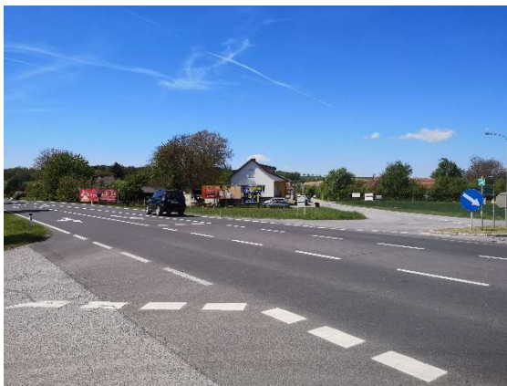
Querungssituation B50 bei Unterschützen
