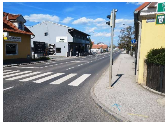
Unterbrechung des kombinierten Geh- und Radwegs an der B50 aufgrund einer Engstelle (Ecke Dornburggasse)
