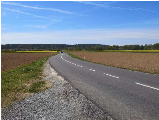
Ohne direkte Verbindung über Zickenbach notwendige Führung im Mischverkehr über Teilabschnitt der Jabinger Landesstraße
