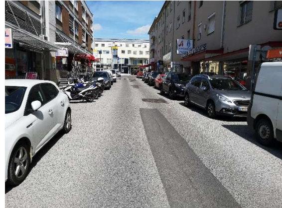
Einbahnabschnitt Schulgasse (Blickrichtung Wiener Straße)
