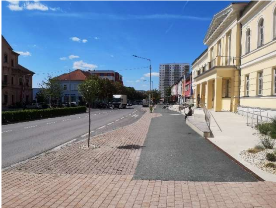
Bestehender Gehweg im Bereich Rathaus bis Bahnhofstraße
