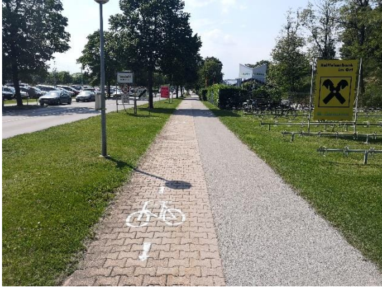
Neufeld: Geh- und Radweg im Bereich Seebad
