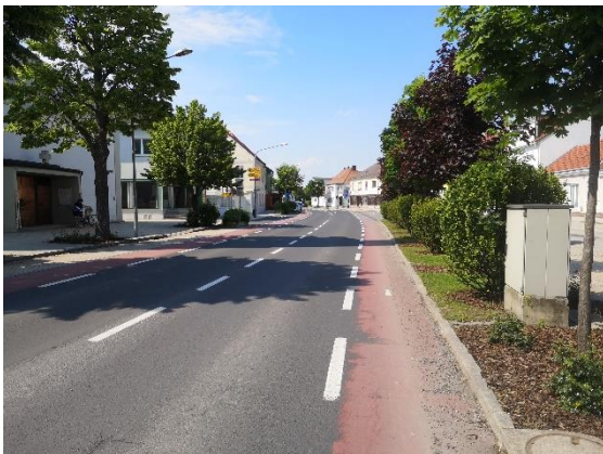
Neufeld: Mehrzweckstreifen in der Hauptstraße
