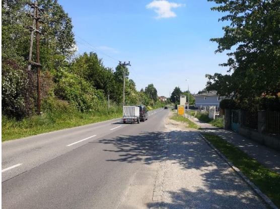
Neufeld: Fehlende Radinfrastruktur in der Steinbrunner Straße L217
