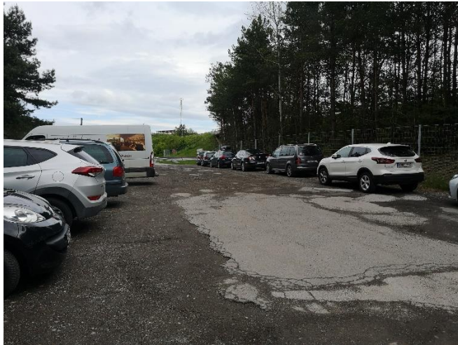
Abbildung 14: P&D Pinkafeld – keine Beleuchtung (und schlechter Allgemeinzustand)
