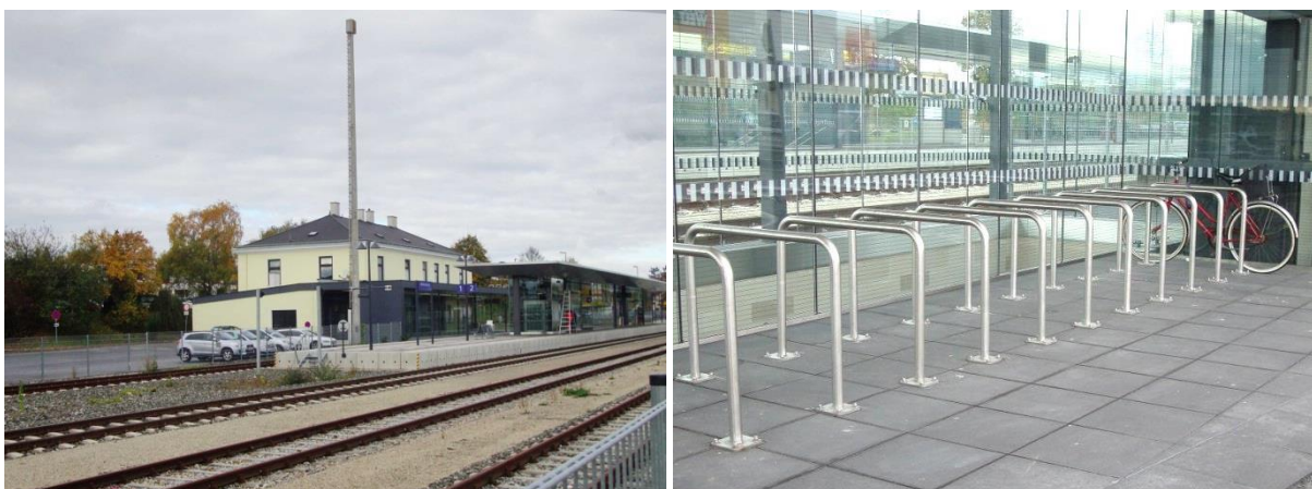
Abb. 9. Modernisierter Bahnhof Mattersburg, überdachte Radabstellanlage (Quelle: eigene Fotos)
