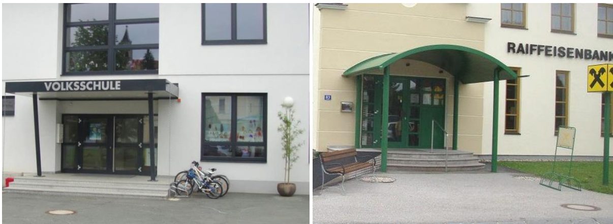
Abb. 4. Fahrradständer Volksschule und Raiffeisenbank (Quelle: eigene Fotos)
