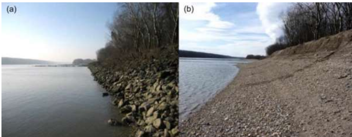
16. ábra A Duna bal partja Witzelsdorf térségében (felvízi irányba nézve) természetes állapotba való visszaállítás előtt (a) és után (b) 2009 (fotók: viadonau)
