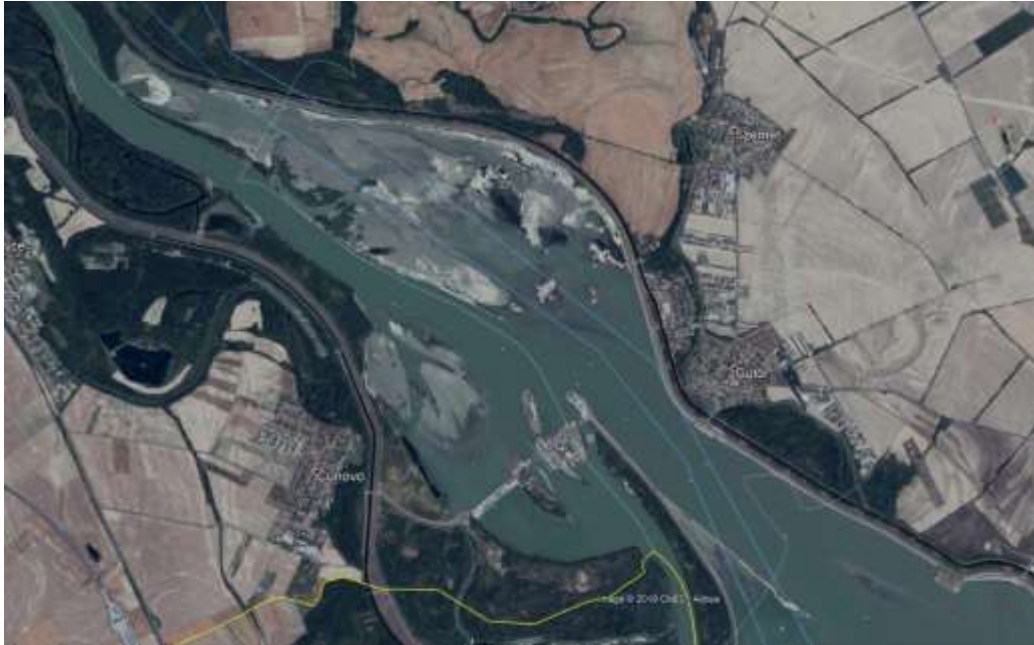
41. ábra Hordaléklerakódási területek a Bósi Vízlépcső felvízi oldalán (Google Earth)
