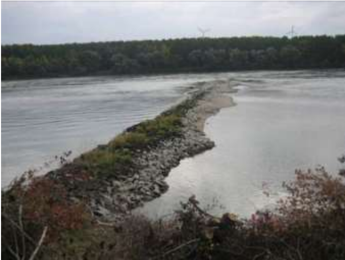
14. ábra Sarkantyú középvízi állapotban (medermélyülés következménye) (Habersack et al., 2012)
