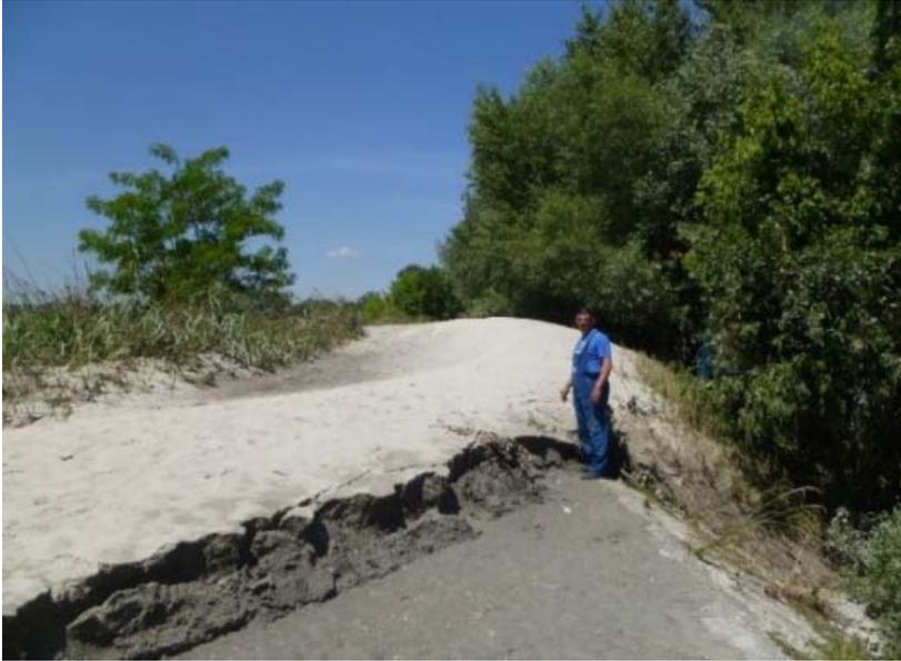
Abbildung 42 Ablagerungen im Vorland während des Hochwassers 2013 in Ungarn (Foto: EDUVIZIG)
