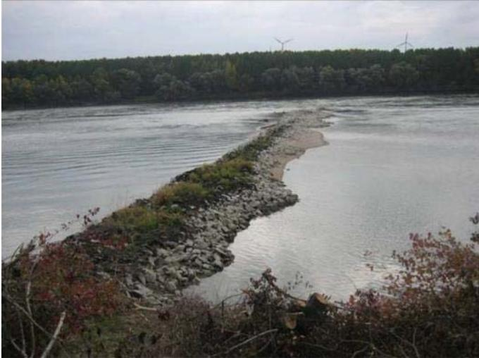
Abbildung 14 Orthogonale Bühnen bei Mittelwasser (als Folge der Sohlerosion) (Habersack et al., 2012)
