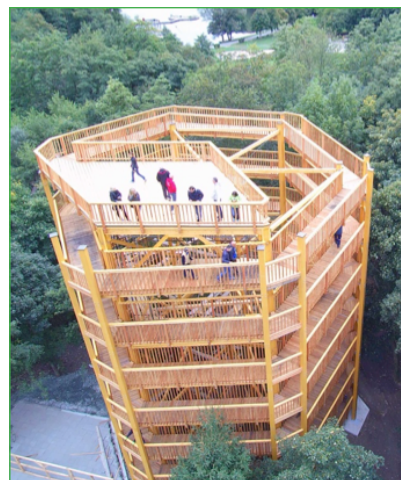
Akadálymentesített kilátó ÍROTTKŐ-GESCHRIEBENSTEIN NATÚRPARK
