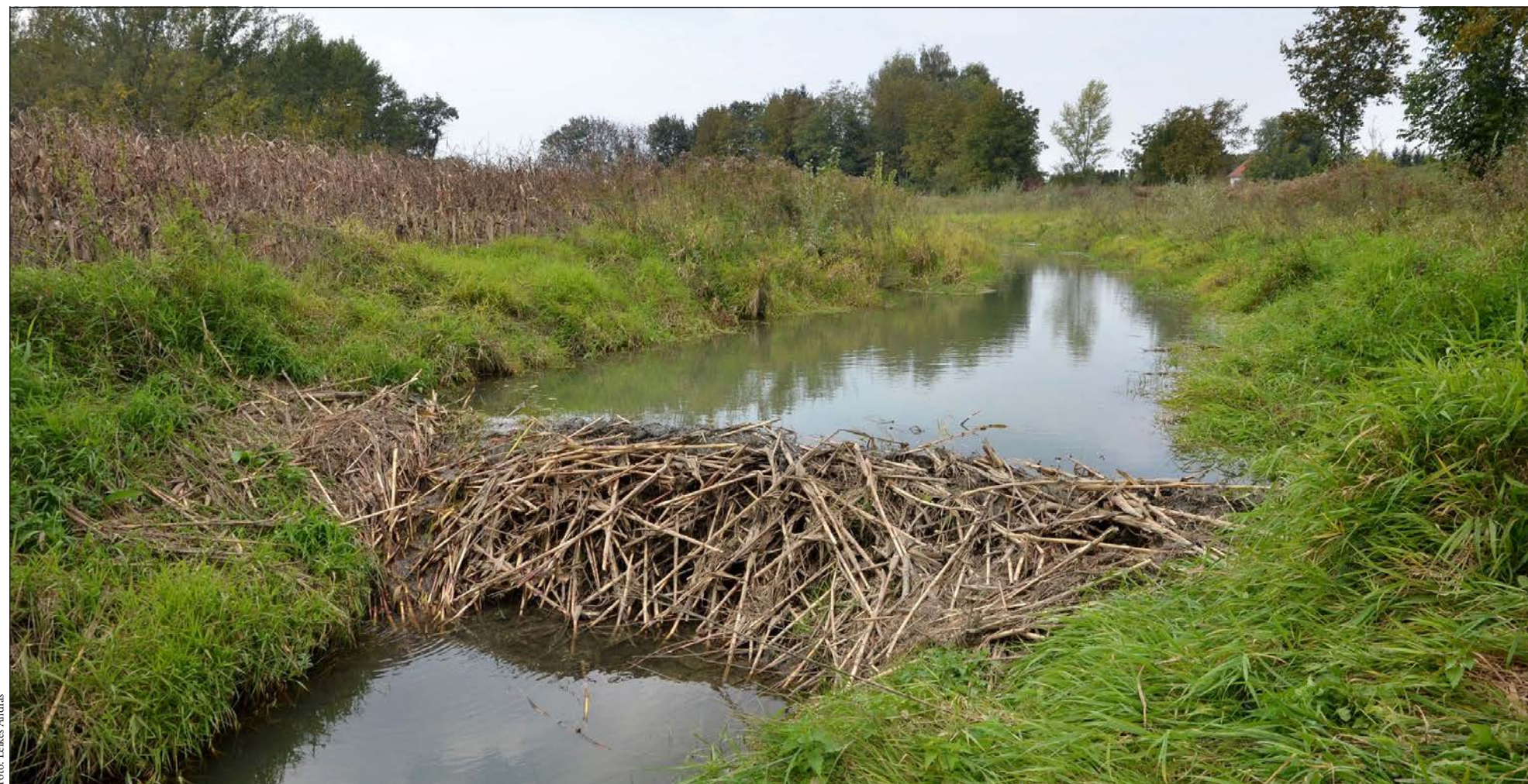
Hódok által épített duzzasztó gát Muraszemenye térségében, a Vöröskői-patakon
