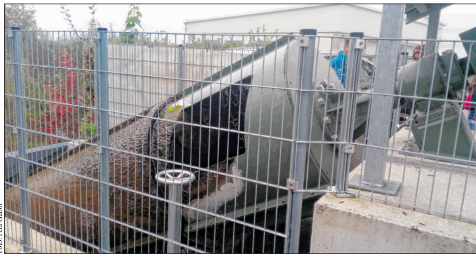
Újszerű halátjáró a gniebigi Lugitschmühlénél, ahol helyhiány miatt egy csigaformájú „halcsavart” építettek be a műtárgyba
