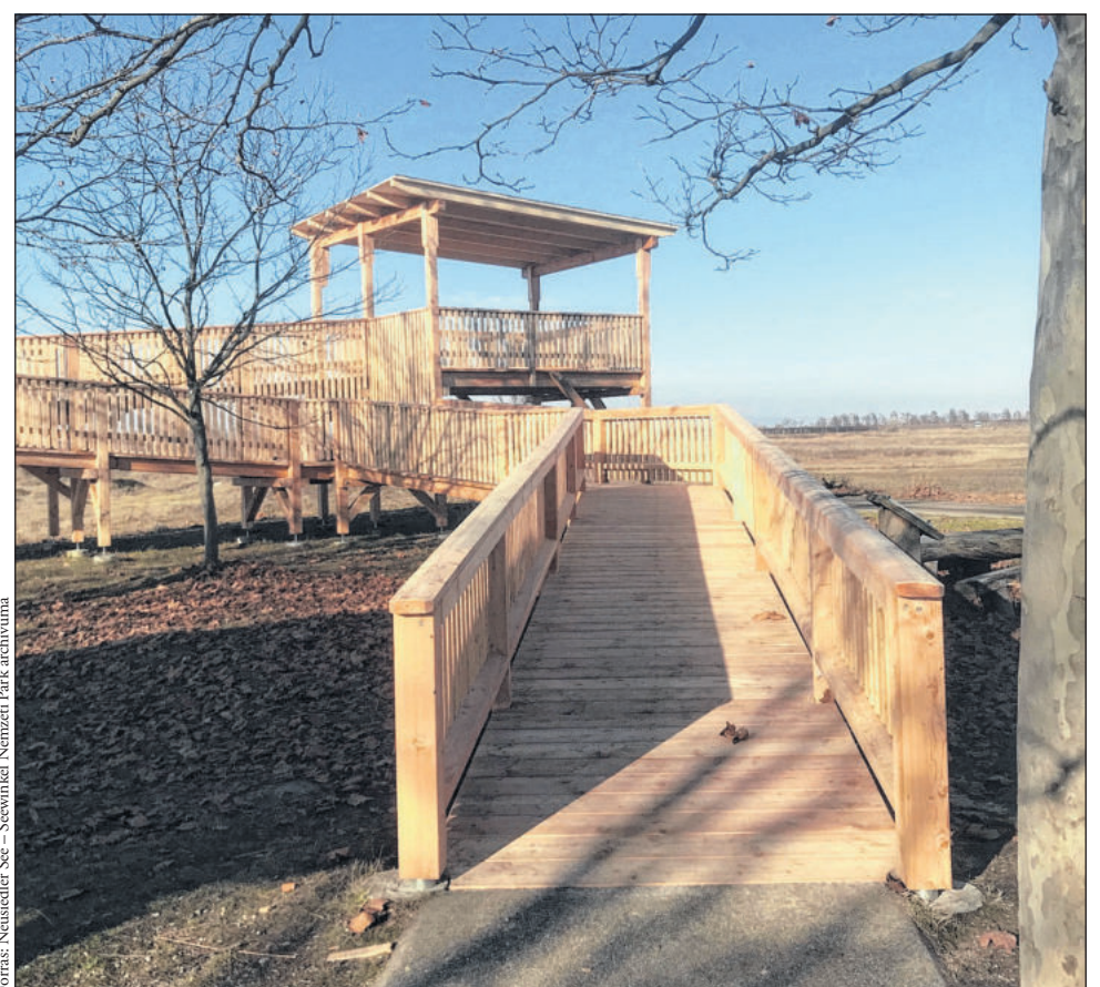
Az Illmic melletti Zicklackén lévő első, kerekesszékekkel megközelíthető megfigyelőhelyet 20 év után át kellett építeni – tetőt kapott, amely védelmet nyújt a nap és az eső ellen.
