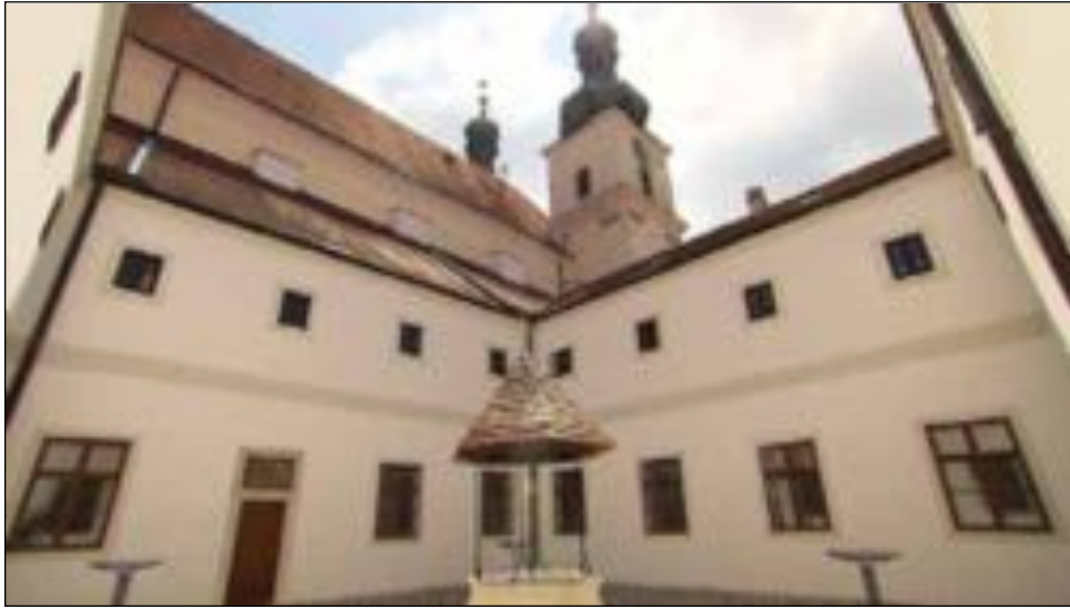
Der Brunnenhof ist mit Granitsteinen gepflastert, das Holzschindeldach wurde erneuert.
