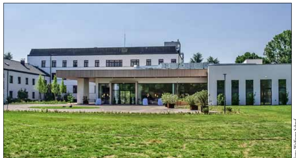
Am westlichen Ortsrand von Mönchhof liegt Marienkron, umgeben von einem weitläufigen Park – Altbestand und Neubau sind vorbildlich miteinander verbunden.
