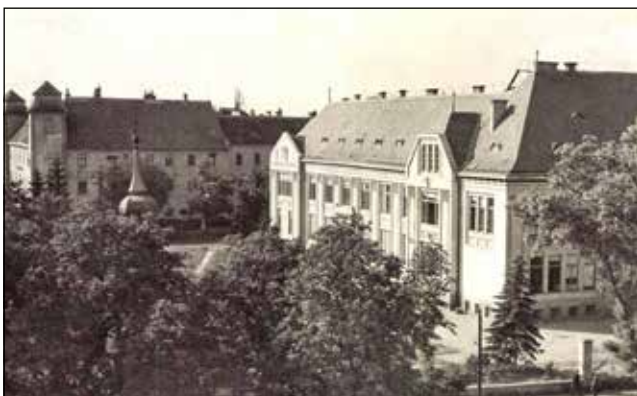
Im Hintergrund dieser Schwarzweißaufnahme aus der Jahrhundertwende ist links die benachbarte Burg zu sehen.
